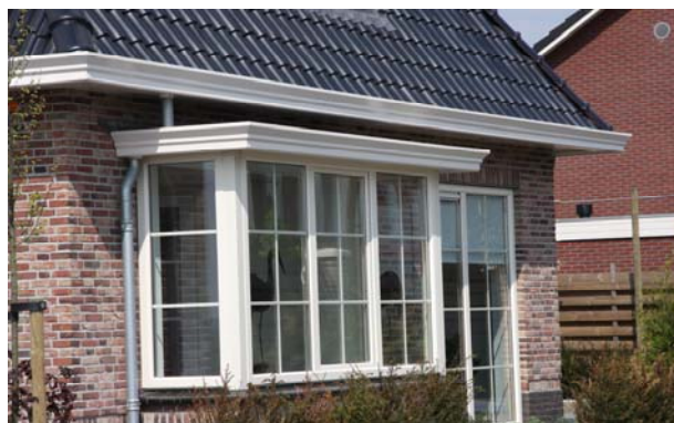
dakrand type Gothiek t.b.v. erker
