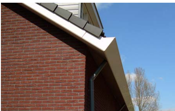
aansluiting windveer/overstek op kopschot V-goot
